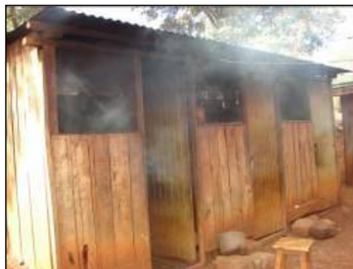
Cocinas con ventilación deficiente
