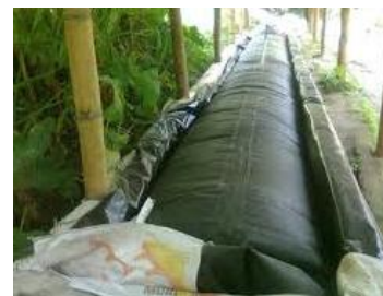
Fig. 2: Biodigestor bajo techo
