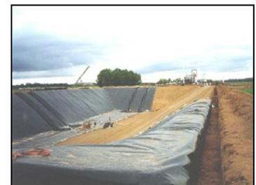
La correcta gestión y las buenas prácticas en los rellenos sanitarios permiten disminuir considerablemente la emisión de metano a la atmósfera. En primer grado, resulta fundamental emplear técnicas para impermeabilizar el terreno mediante revestimientos en la base y una cobertura diaria del suelo, de forma que el biogás producido (con alto porcentaje de metano) no se fugue directamente a la atmósfera.
